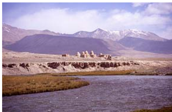
تصویر ۱۰ : محل و رودخانه "بزی گنبد" در شمال محل اتصال با رودخانه و اخان. تابستان ۲۰۰۴ [۷].
